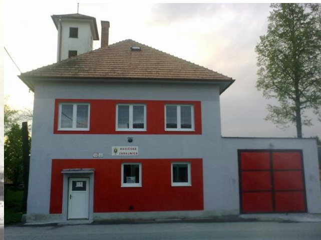
Po rekonštrukcii a úpravách rok 2012.
