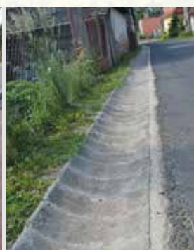
Na kritických úsekoch sme vyčistili, prehĺbili a vybudovali nové odvodňovacie rigoly - na ul. Obrancov mieru, medzi ul. Cintorínska a Osloboditeľov.
