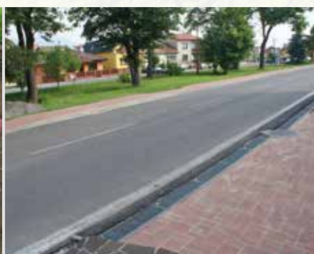
Na kritických úsekoch sme vyčistili, prehĺbili a vybudovali nové odvodňovacie rigoly - na ul. Obrancov mieru, medzi ul. Cintorínska a Osloboditeľov.
