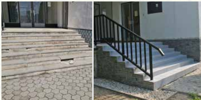
Obecná firma tiež realizovala celkovú opravu poškodeného schodiska na vstupe do Domu smútku a nový obklad sokla. Stavebné úpravy zvýšili dôstojnosť tohto miesta, sami posúďte.
