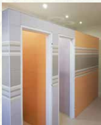
Dievčatá majú zrekonštruovanú šatňu pri telocvični v základnej škole, rekonštrukciu realizovala firma Obecné služby Spišská Teplica s.r.o.
