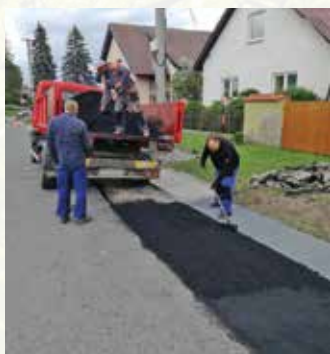
Opravy sa dočkali aj ostatné miestne komunikácie, výtlky v rozsahu cca 250m 2 vyspravila obecná firma Obecné služby Spišská Teplica s.r.o. Na ich opravu v celej obci sa použilo viac ako 40 ton asfaltu.
