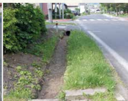
Na kritických úsekoch sme vyčistili, prehĺbili a vybudovali nové odvodňovacie rigoly - na ul. Obrancov mieru, medzi ul. Cintorínska a Osloboditeľov.
