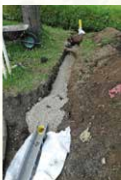
Na kritických úsekoch sme vyčistili, prehĺbili a vybudovali nové odvodňovacie rigoly - na ul. Obrancov mieru, medzi ul. Cintorínska a Osloboditeľov.
